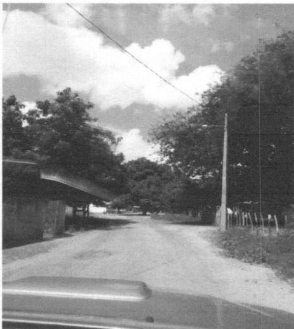
FOTOS 09 – TRECHO DA ESTRADA VICINAL POV BOA VISTA. 812063.00 m E 9643127.00 m S
