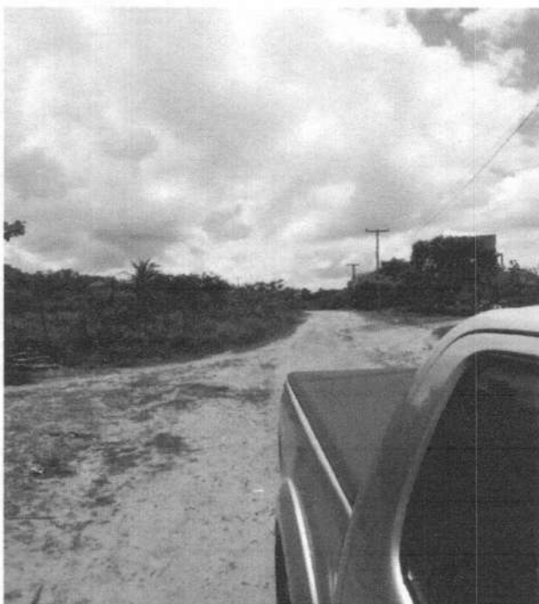
FOTOS 12 – TRECHO DA ESTRADA VICINAL POV RETIRO.
