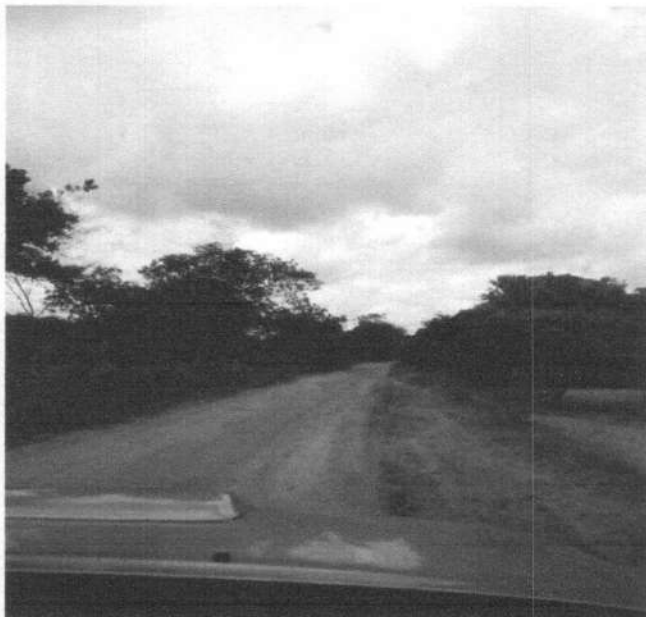
FOTOS 11 – TRECHO DA ESTRADA VICINAL POV RETIRO.
