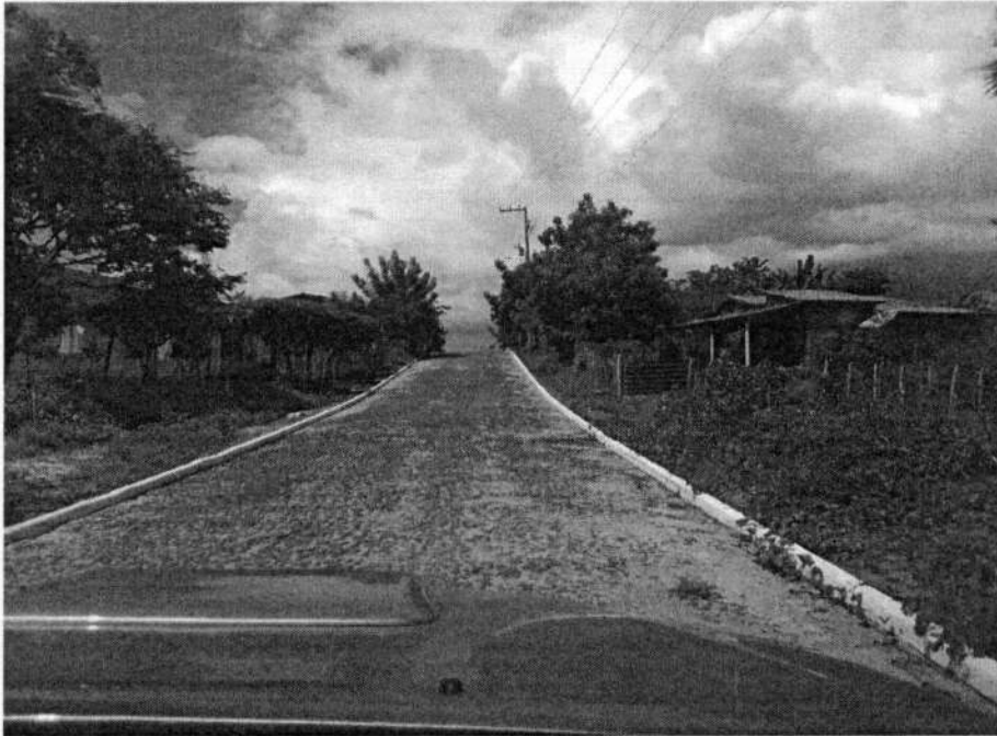
FOTOS 23 – TRECHO DA ESTRADA VICINAL POV ENTRE LADEIRAS. 807218.00 m E 9639374.00 m S
