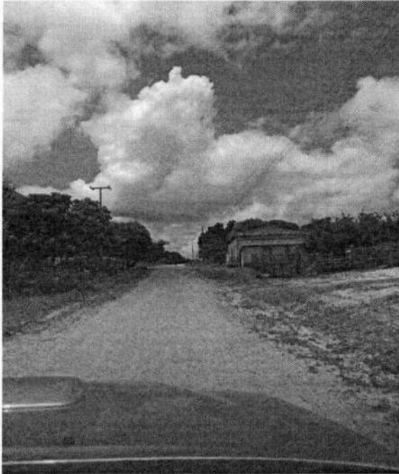
FOTOS 15 – TRECHO DA ESTRADA VICINAL POV VAZANTINA. 807960.00 m E 9642019.00 m S
