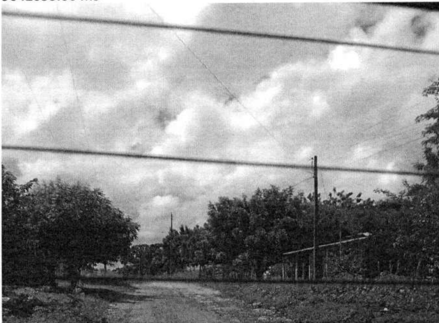
FOTOS 08 – TRECHO DA ESTRADA VICINAL POV SANTO INACIO. 814042.00 m E 9642481.00 m S
