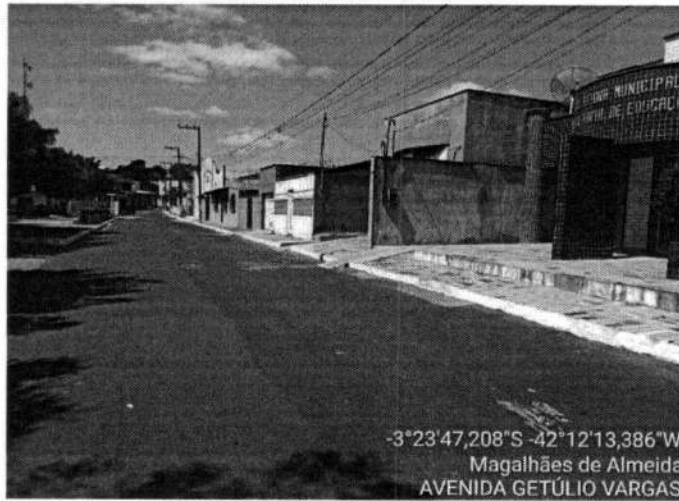
AVENIDA GETÚLIO VARGAS TRECHO 02
