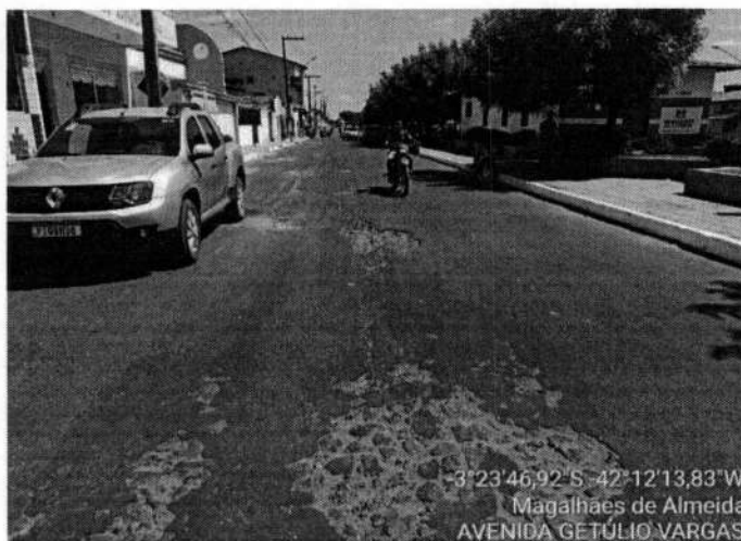
AVENIDA GETÚLIO VARGAS TRECHO 01
