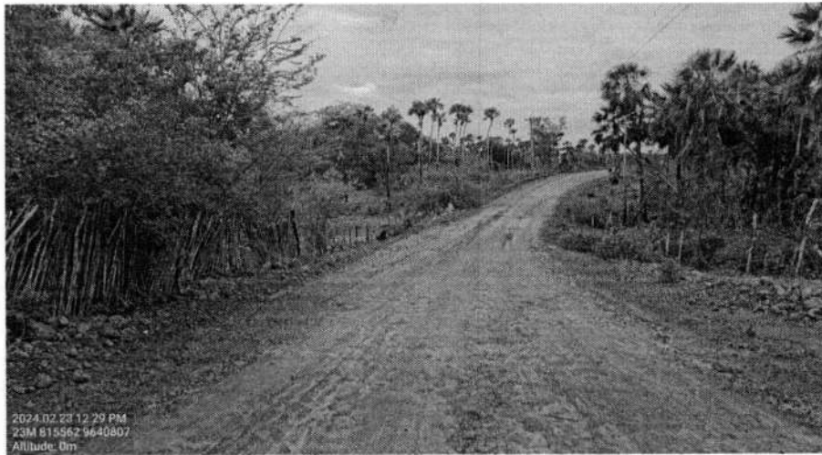
FOTO 1 - INÍCIO DO TRECHO
