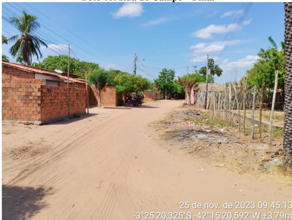
Foto 06: Rua do Campo – Final
