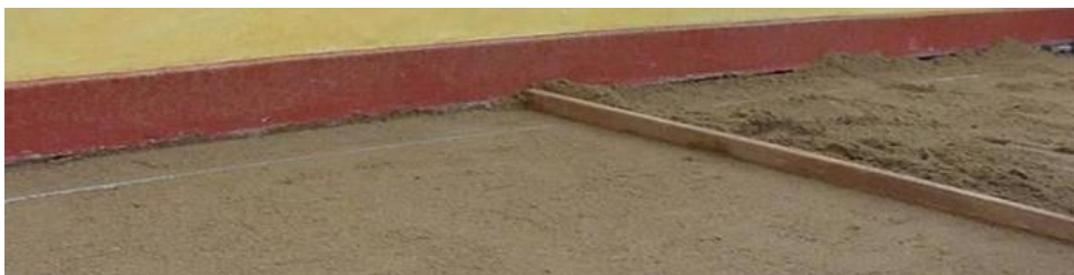
Foto 02- Camada de assentamento
