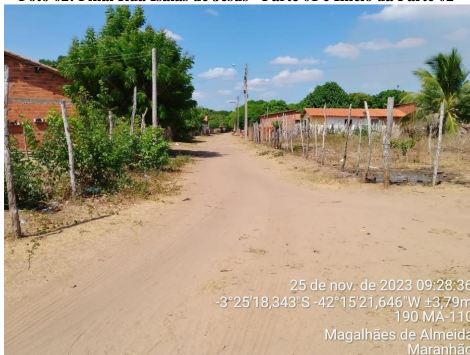
Foto 02: Final Rua Isaias de Jesus - Parte 01 e Início da Parte 02
