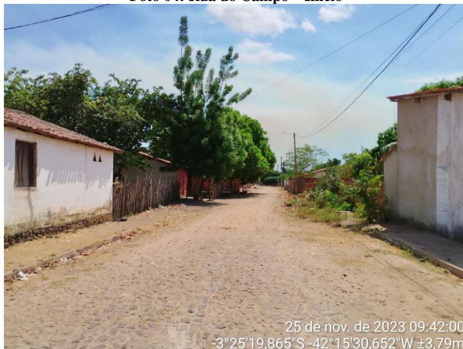
Foto 04: Rua do Campo – Início
