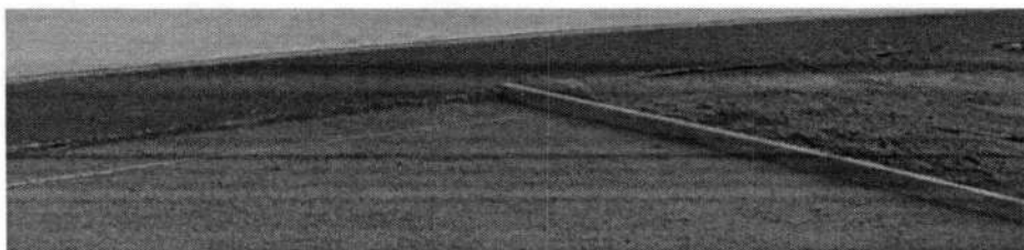
Foto 02- Camada de assentamento
